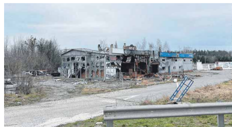
Kriegsschäden an Häusern und Betrieben prägen das Bild bei einer Fahrt durch die Ukraine.
