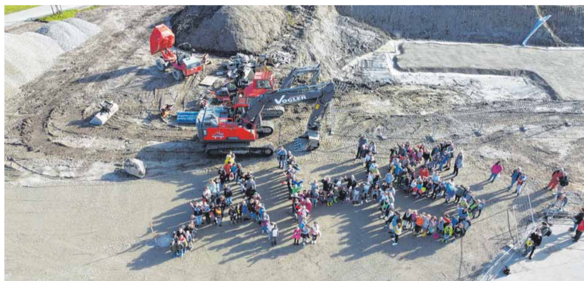
Die rund 170 Kinder und Jugendlichen der Antonio-Huber-Schule freuen sich: Läuft alles nach Plan, dann werden sie ab Herbst 2024 in einem modernen Neubau für das Förderschulzentrum lernen. Der Landkreis Lindau lässt sich das Projekt in Lindenberg gut 18 Millionen Euro kosten. Beim per Bagger ausgeführten symbolischen Spatenstich formt der Nachwuchs die Initialen AHS seiner Schule. FOTO: ALEX KLÖSGES / BÜRO ANDERGASS
