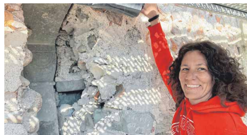
Bauleiterin Viola Rein hebt die Pläne an. Zum Vorschein kommt ein Geheimnis, das Bauarbeiter bei der Sanierung des Kirchturms von St. Stephan freigelegt haben: die Säule eines ehemals dreiteiligen Fensters aus romanischer Zeit. Gefunden haben sie Bauarbeiter, als sie den Putz entfernt haben. Nach Einschätzung von Michael Pfanner, dessen Fachbüro aus Scheffau die Bauleitung innehat, ist die Säule eines der ältesten Ornamentbauteile in Lindau. FOTO: BARBARA BAUR
